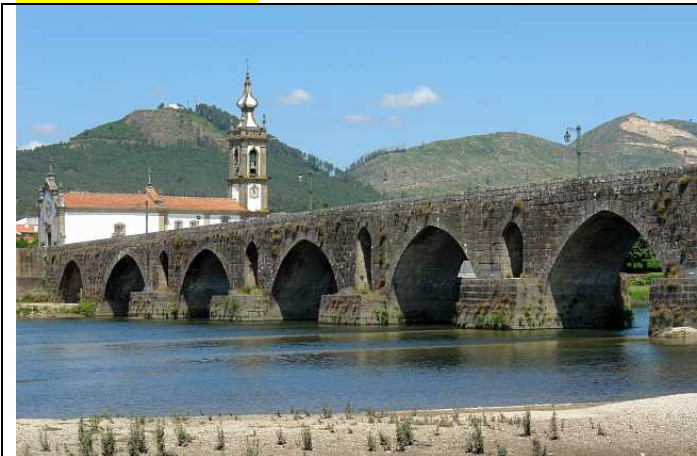
Puente sobre el río
