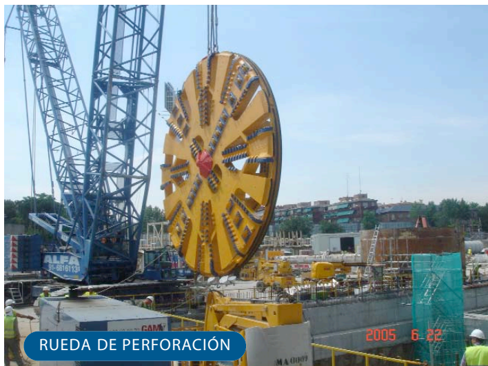
CABEZA DE LA TUNELADORA
