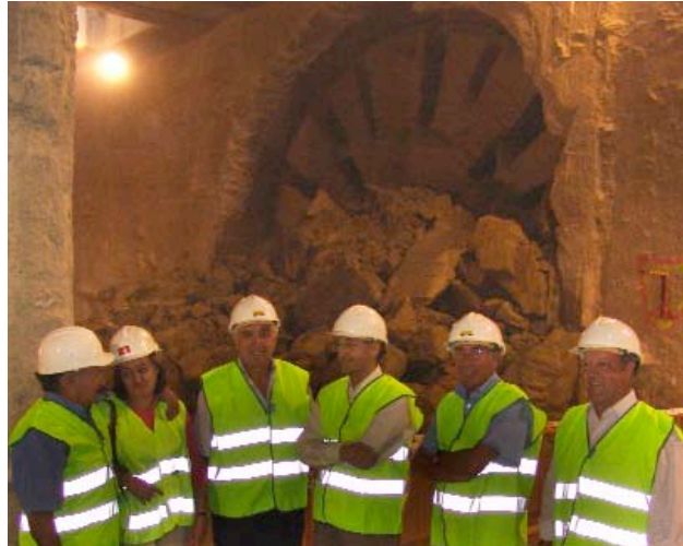
Directivos de AO-2000 a la llegada de la tuneladora
